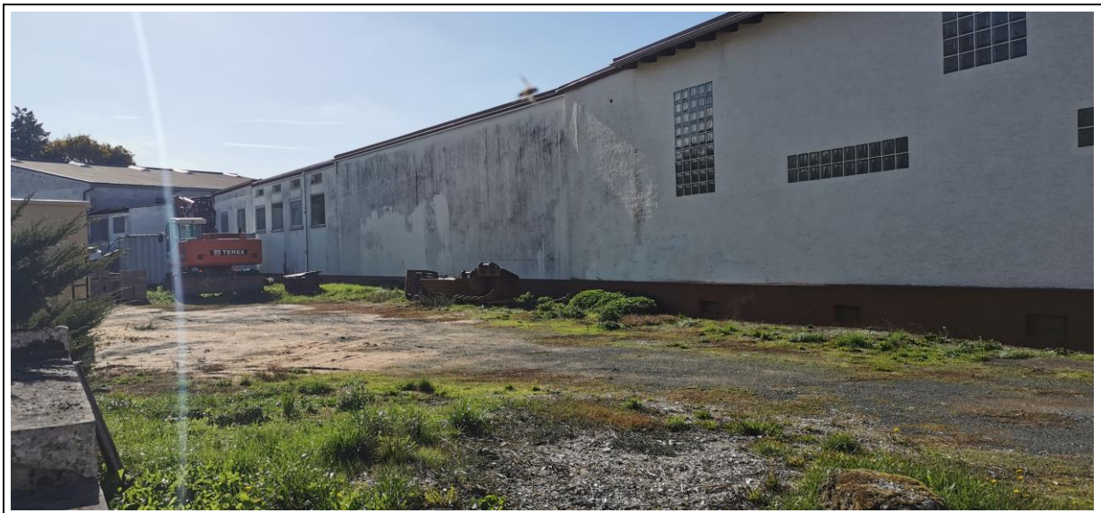
Abbildung 7: Lagerflächen und Grenzbebauung
